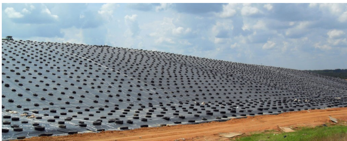
شکل ۲-۴- کاربرد ژئوممبرین در محل‌های دفن پسماند؛ اجرا بر روی لاینر رسی ژئوسیننتیکی (بالا راست)، اجرا بر روی لاینر رسی متراکم‌شده (بالا چپ) و اجرا جهت پوشش نهایی (پایین)
