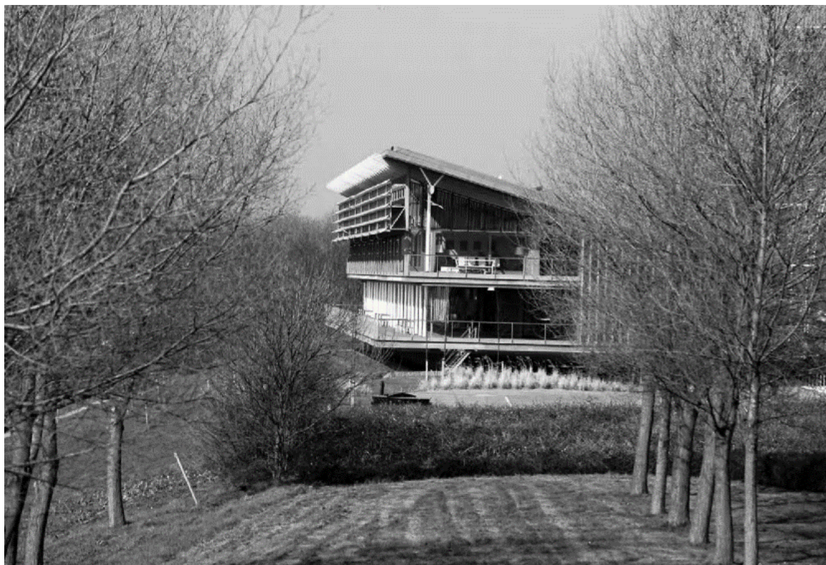
شکل ۲-۳۸- ساختمان اجرا شده بر روی لندفیل Nauerna در هلند
