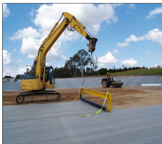
شکل ۲-۱۰- پهن کردن رول GCL به صورت مکانیکی و دستی
