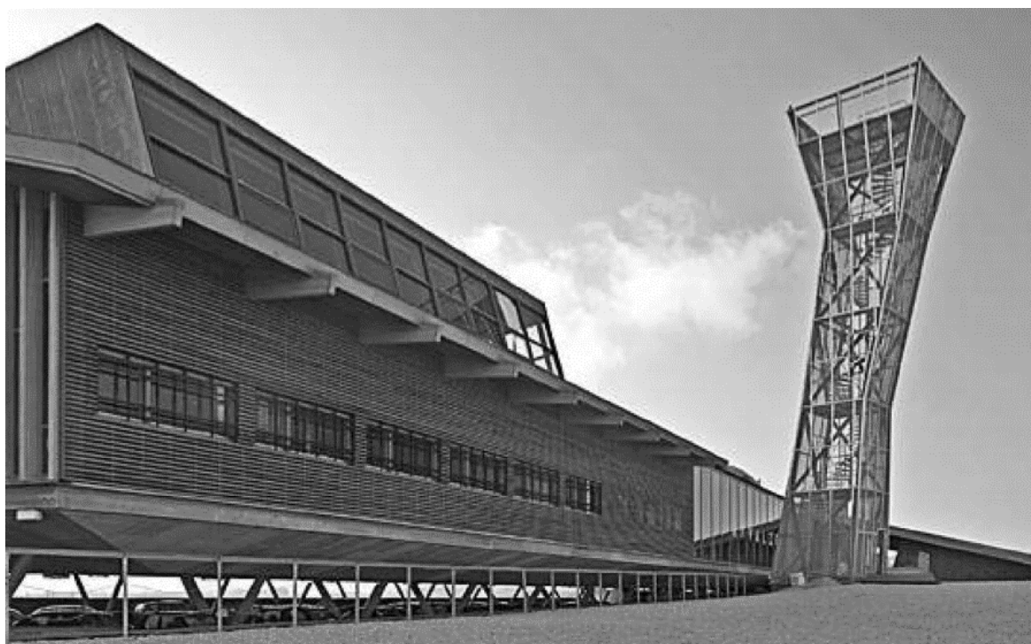
شکل ۲-۳۶- سیستم تهویه‌ی ایجادشده در زیر یک ساختمان اداری احداث شده روی لندفیل (هلند)
