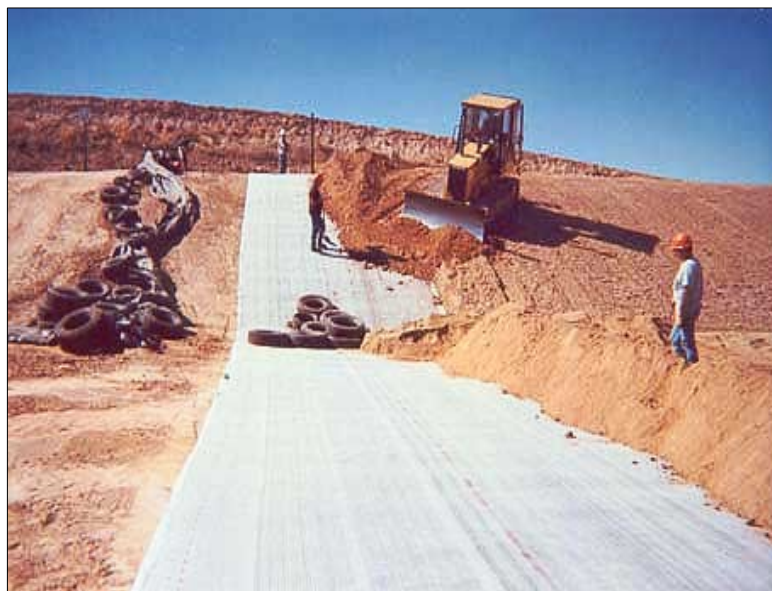
شکل ۲-۹- اجرای لایه‌ی پوششی بر روی GCL
