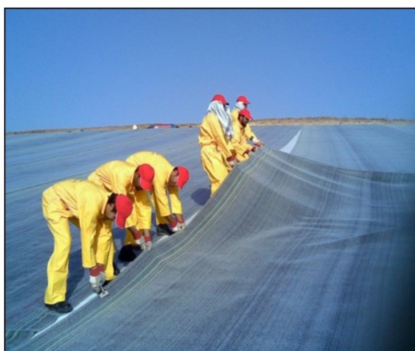
شکل ۲-۱۰- پهن کردن رول GCL به صورت مکانیکی و دستی
